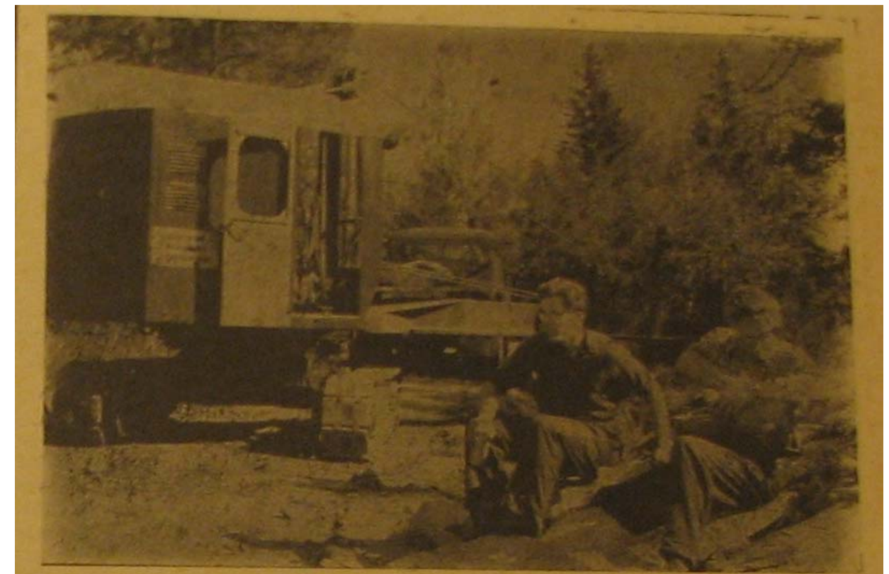
VÄGBYGGEN utgör en viktig detalj i »sommarstadens» tillblivelse och här har grävskopeskötaren Kjell Ronnermark (t. v.), Björnö, och lastbilschauffören Bo Lindahl, Bergshamra, tagit sig en välbehövlig kaffepaus i sommarbattan.
