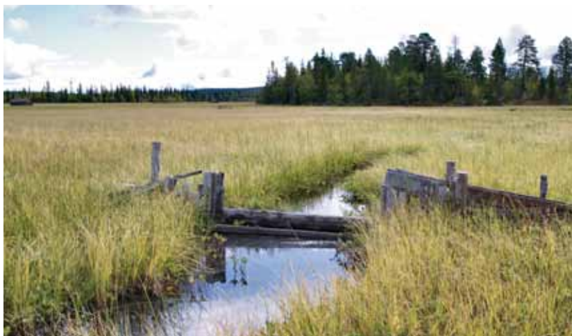
Dammäng med uppbyggd fördämning. Heikkamavuoma i Norrbotten.
